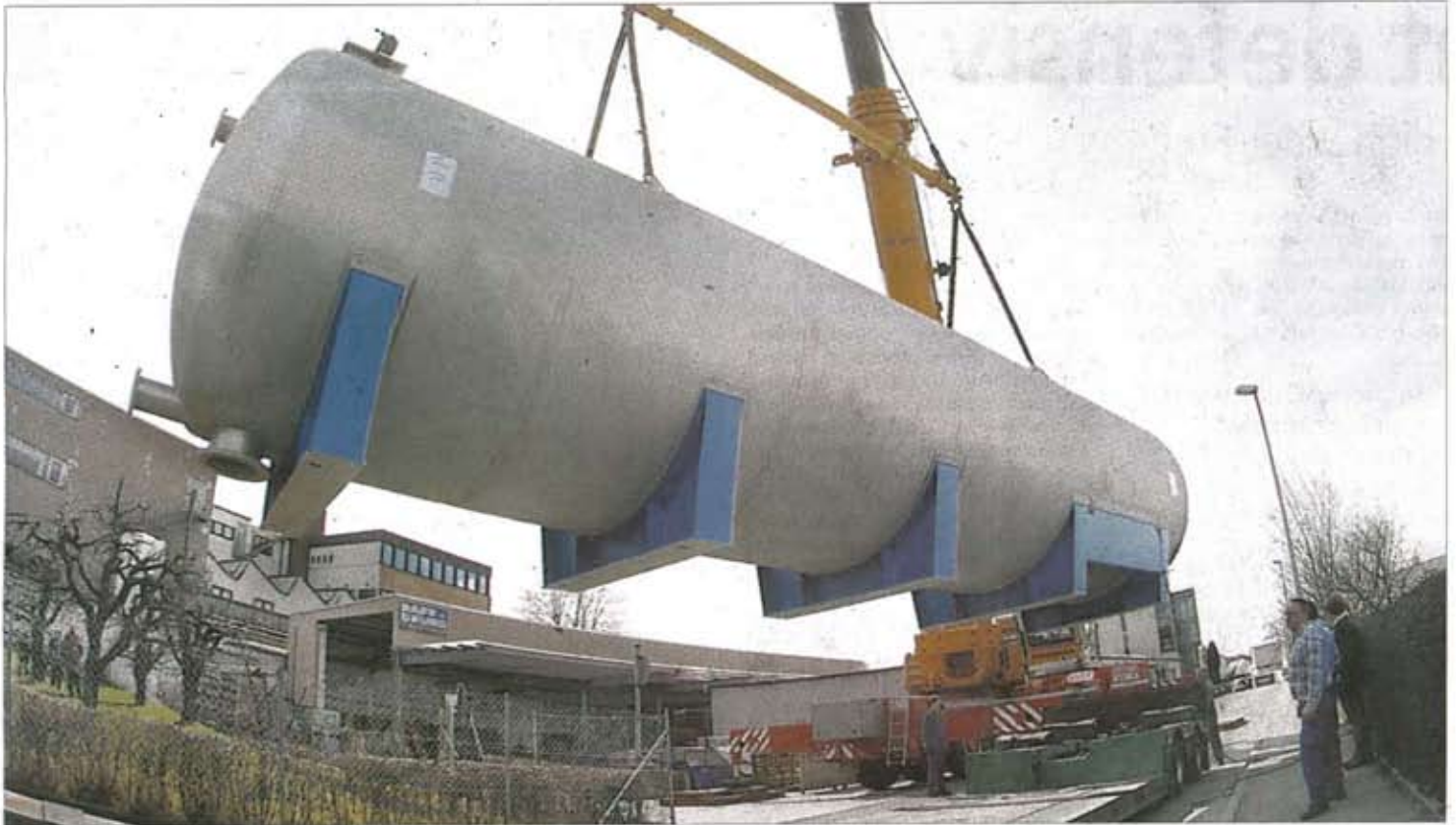
90 Kubikmeter fasst dieser in Freiberg gefertigte Edelstahltank, der künftig am Persischen Golf eingesetzt werden wird:
